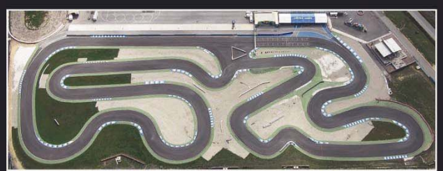
Carretera del Palmar, Conil de la Frontera (Cádiz) CircuitoKR24
